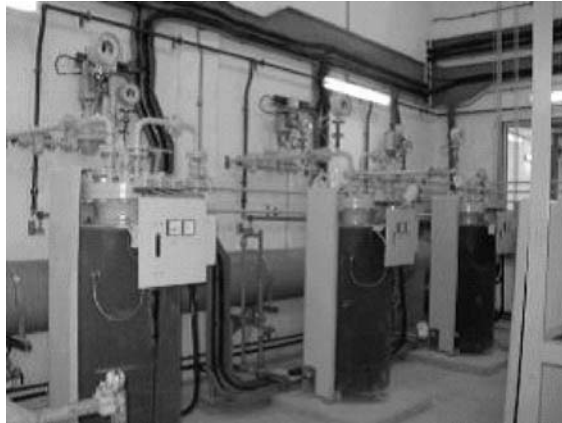
Сл. 4 Унутрашњост хлорне станице
